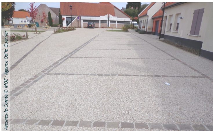
Béton et pavés
